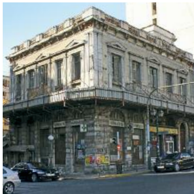
Το κτήριο στη γωνία Γρηγορίου Λαμπράκη και Τσαμαδού 8 στον Πειραιά. Αρχιτ. Ε. Τσίλλερ.
